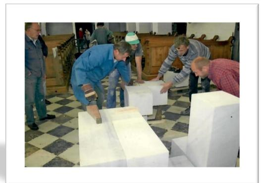
Der Stein wird mit Diamantsägen in 14 verschiedenen geformten Steinteile geschnitten, die zusammengesetzt in der Vorderansicht 3 mal 5 Quader von 31 cm mal 31 cm ergeben. Die 6 Bohrkern für den Ambo werden leicht schräg. Die Bodenplatten haben auch 31 cm mal 31 cm. *Bemerkung Zufall?*
